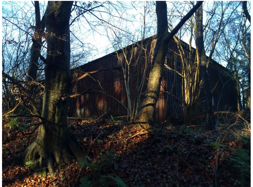
Halle in Neu Duvenstedt
